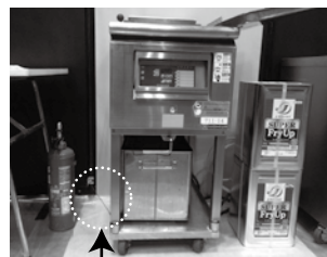
据え置き型電気フライヤーの壁面とのワイヤーを使用した固定例
